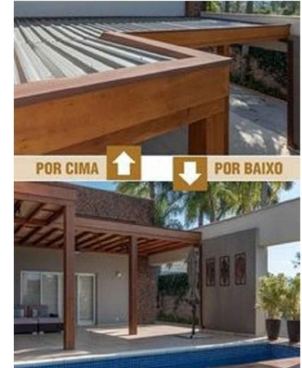
ILUSTRAÇÃO DA INTERNET QUE MOSTRA A SOLUÇÃO ADOTADA PARA FAZER A COBERTURA DO PERGOLADO + O ACABAMENTO ENTRE OS CAIBROS E A TELHA PARA ESCONDER A PARTE TÉCNICA.
