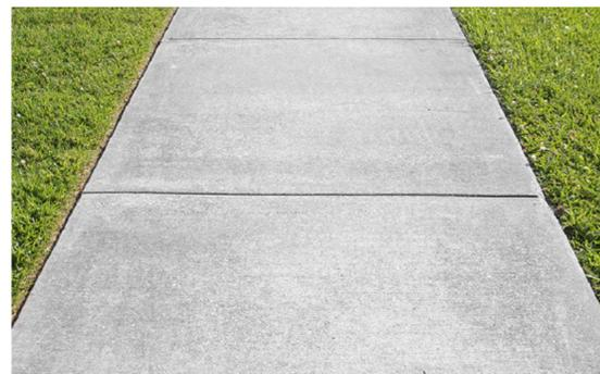
O CALÇAMENTO EM VOLTA DO CIRCUITO SERÁ FEITO DE CONCRETO COM O ACABAMENTO MAIS LISO, CONFORME MOSTRA A ILUSTRAÇÃO. PARA EVITAR TRINCAS, A CADA UM METRO, PREVER JUNTAS DE DILATAÇÃO.
